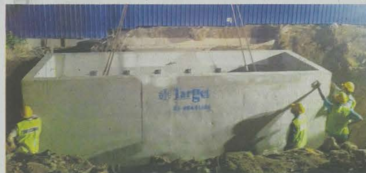
LURANG pratuang ( pre-cast manhole ) diturunkan ke dalam tanah.
